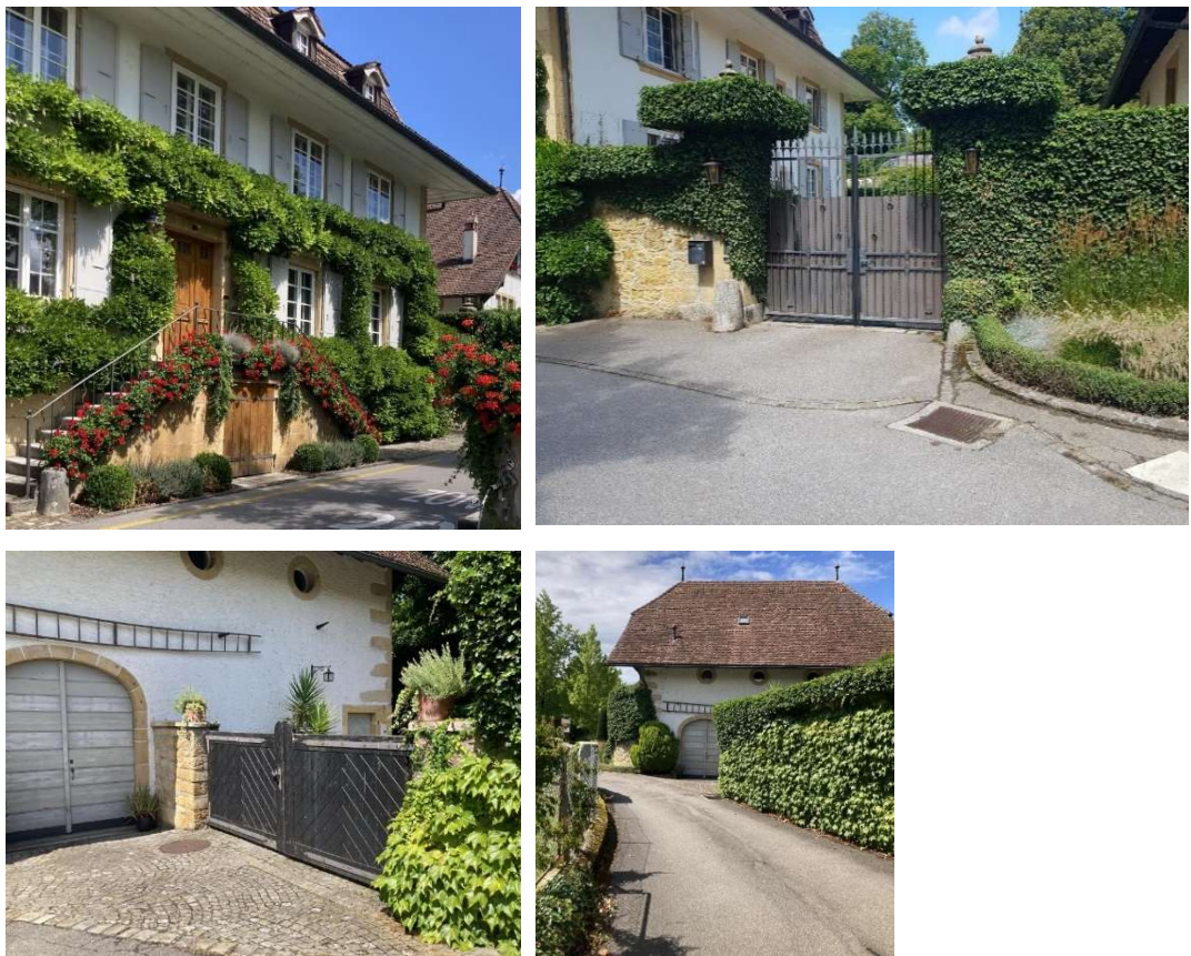
Abbildung 8: Holztür Gebäude Nord (oben rechts), Portal Zufahrt Gebäude Nord (oben links), tiefliegendes Portal / Tor Gebäude Süd (unten)
